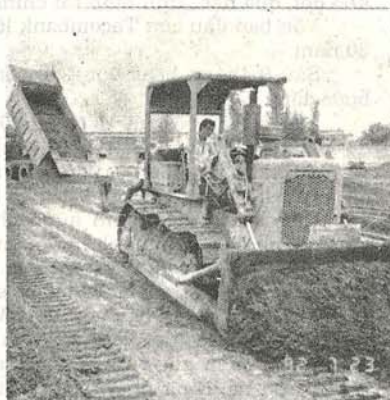
Thi công xây dựng khu chế xuất Tân Thuận giai đoạn I
